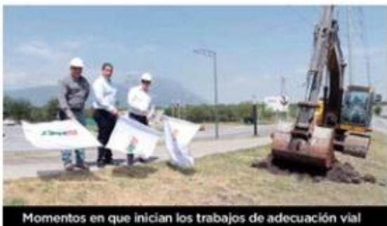
Momentos en que inician los trabajos de adecuación vial
